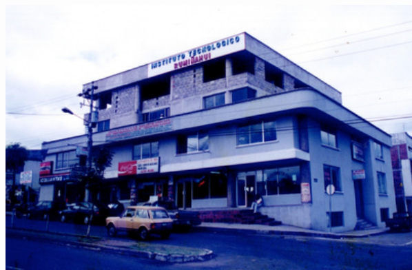
Antigua edificación del Universitario Rumiñahui.
